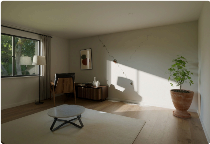
Foto 1.1 · Vista general del muro con la ventana. Diseño de referencia.
