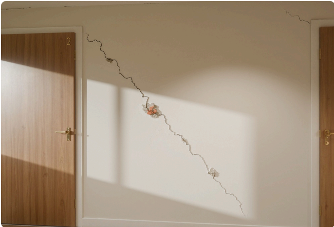
Foto 2.1 · Fisura en el dintel de la puerta. Diseño de referencia.
